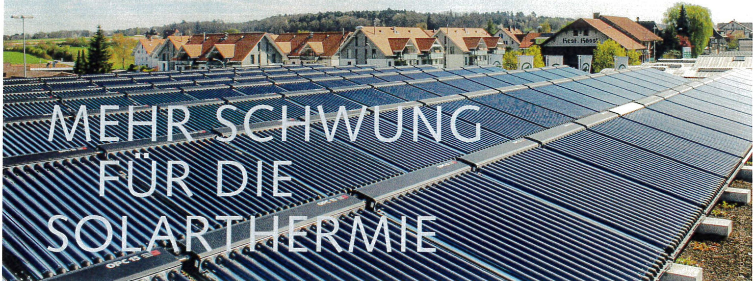
Kollektoranlage des Wärmeverbunds Lyssach-Schüpfen mit einer Fläche von 460 m 2
